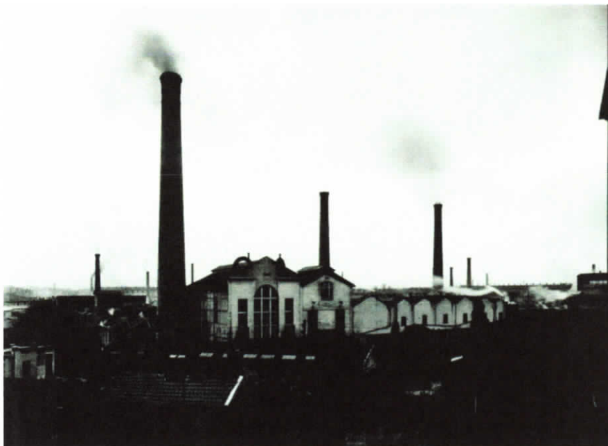
Usine Gillet à Villeurbanne
