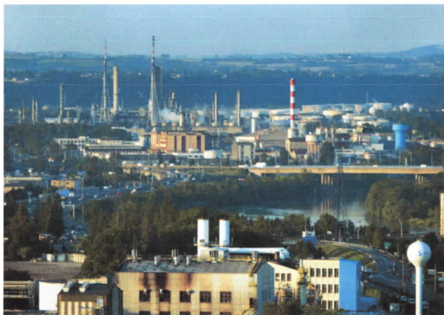
Au sud de Lyon, le début du "couloir de la chimie"
