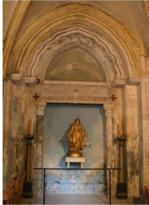
Porte murée qui conduisait de la galerie à la nef de la chapelle. L'inscription date du XVe siècle mais l'ensemble a sans doute été remanié au XIX e siècle.
