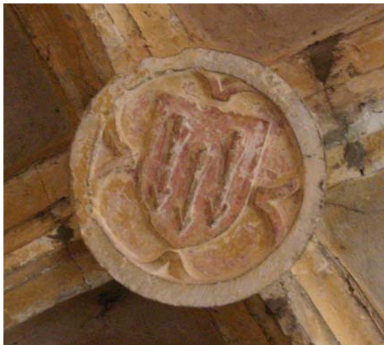
Clé de voûte armoriée dans la galerie
