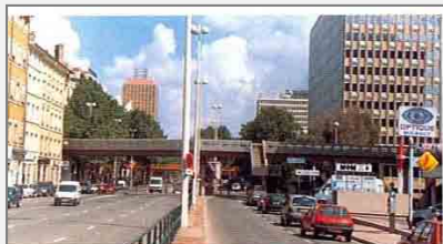
Vue de la rue Garibaldi avant la démolition de la passerelle.
